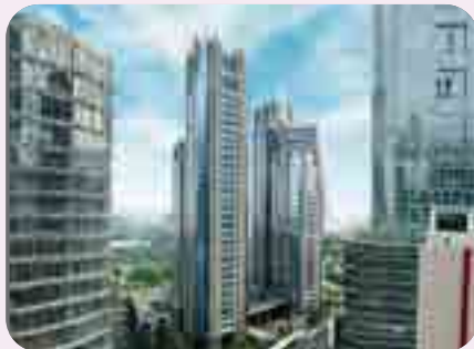
Gedung Bursa Efek Indonesia
